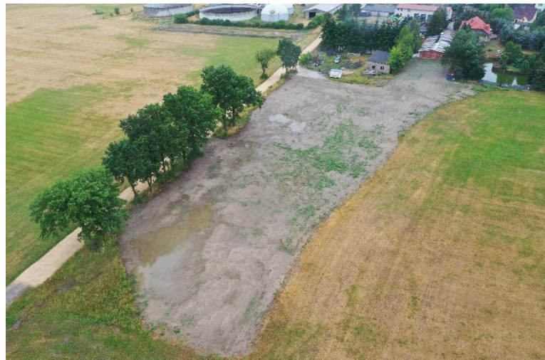
Maßnahme­fläche nach Be­en­di­gung Abbrucharbeiten
