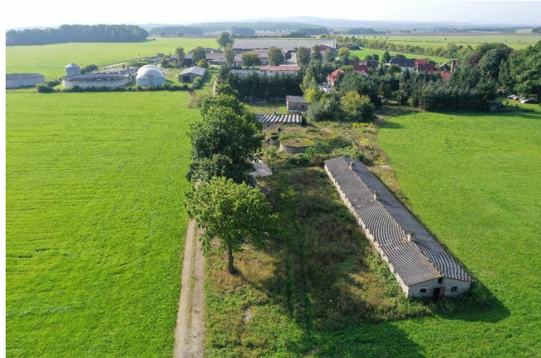
Maßnahme­fläche vor Beginn der Abbrucharbeiten
