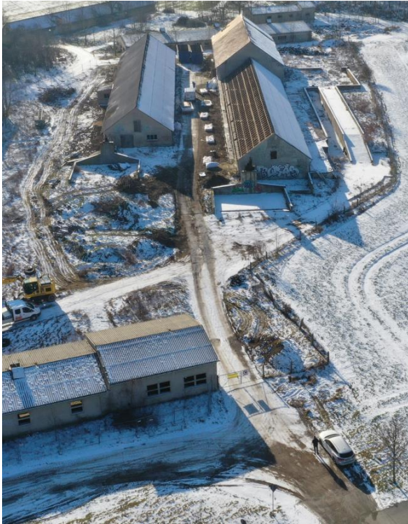
Bild 2: Maßnahmenfläche Anfang Februar 2023
