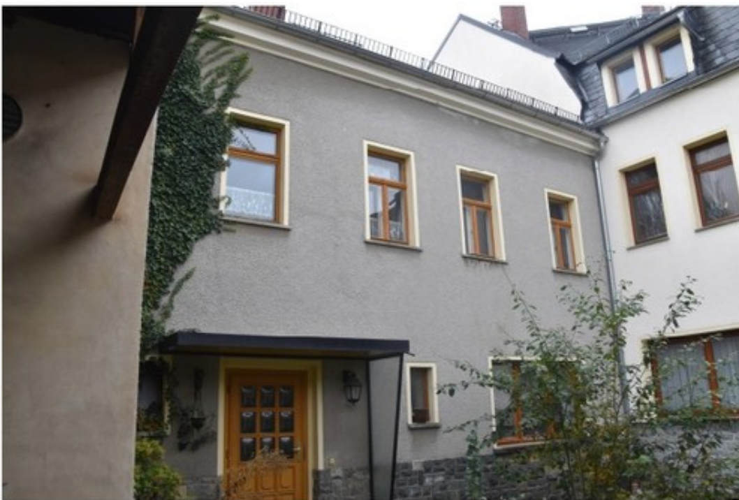
Rückansicht Gebäude Gablenzer Straße 1
